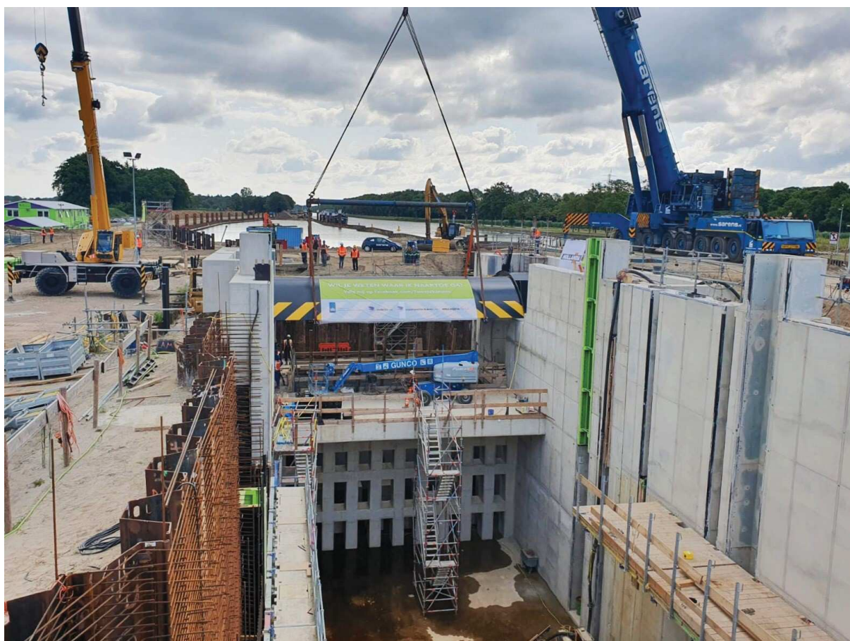
De segmentdeur werd vorig jaar zomer ingehangen door Lock2Twente. Foto: Rijkswaterstaat
